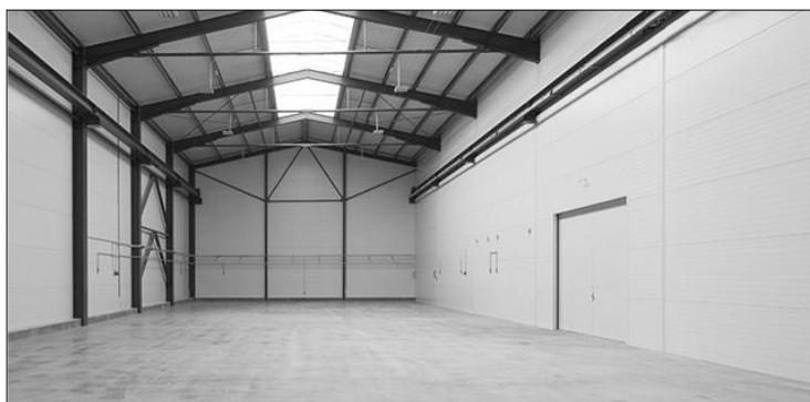
Obr.2 Hala osvětlená difúzně zasklenými světlíky
