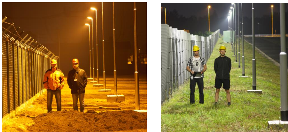
Obr.2 Pohled na hlídací osvětlení v areály elektrické stanice TR Čechy střed vlevo (HPS), a v areály TR Nošovice vpravo (LED)
