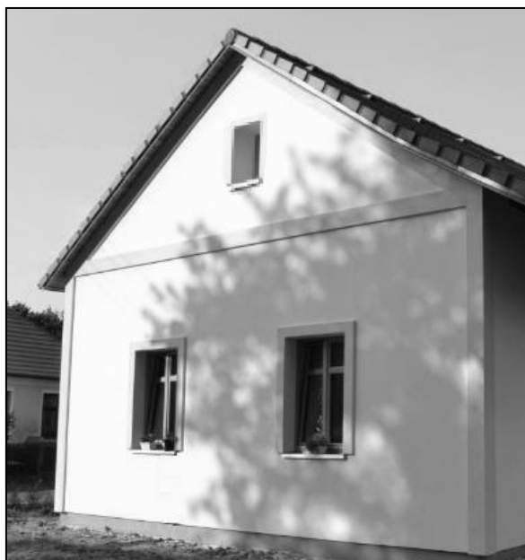
Obr.3 Průčelí vesnického domu, které je zčásti osvětlené přímým slunečním zářením.
