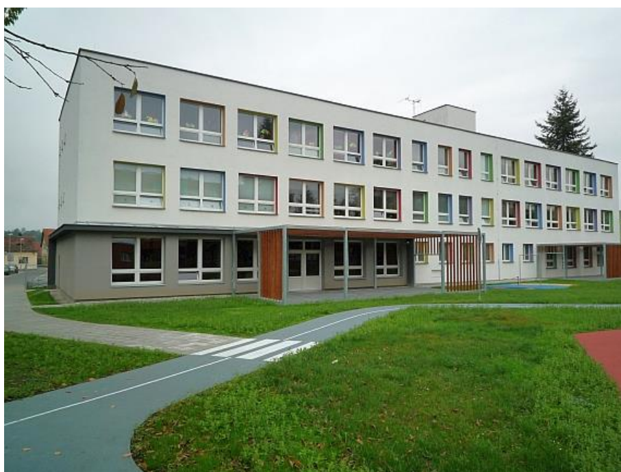
Obr.2 - pohled na posuzovaný objekt
