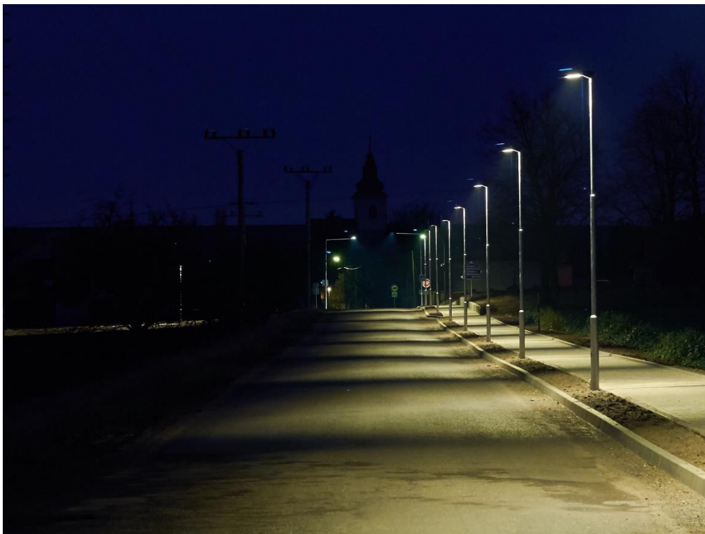
Obr.3 Soustava VO s nedostatečnou rovnoměrností jasů
